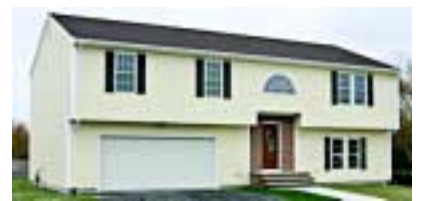
Casas novas em construção EAST PROVIDENCE $349.900
